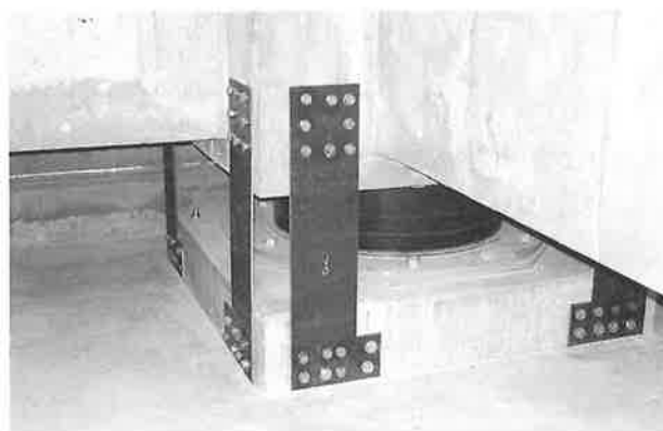
写真一四 固定版取付状況
