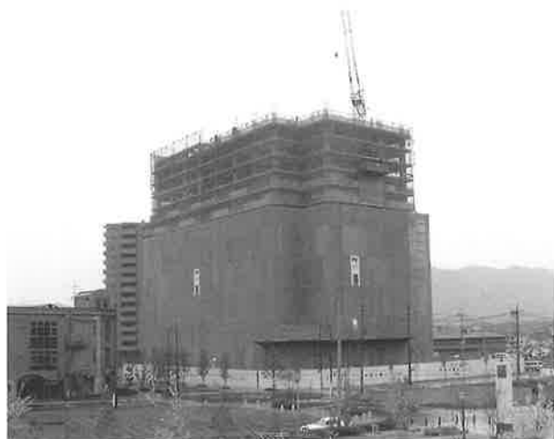
写真一五 建物施工状況
