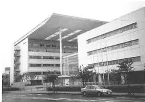
写真-1 建物全景
