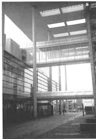
写真-7 連絡ブリッジ
