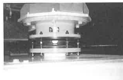
写真-4 摩擦皿ばね支承
