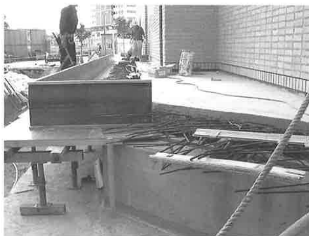
写真-7 犬走りの施工の様子
