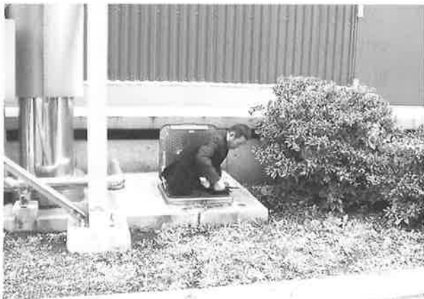
写真一六 免震層への入口
