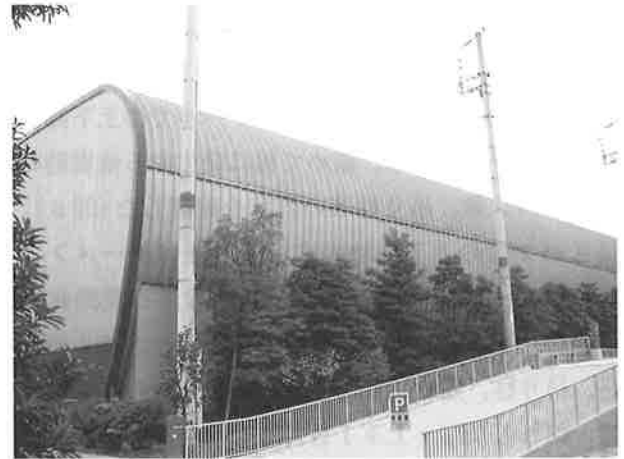
写真-1 建物外観
