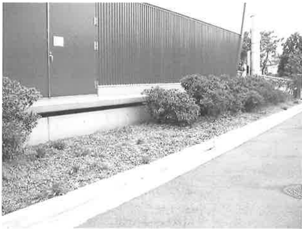
写真一五 建物外周の犬走り
