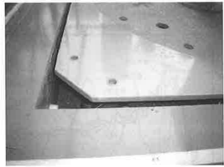
(3) コンクリート充填状況②
