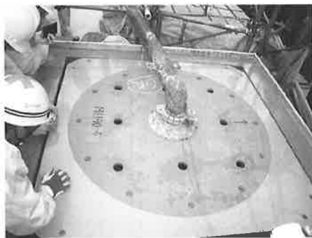
(2) コンクリート充填状況①
