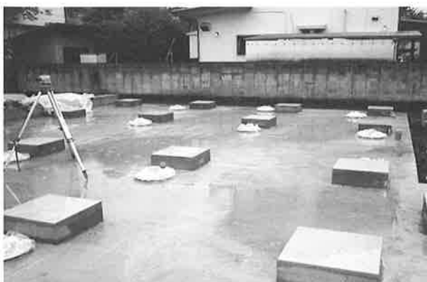
写真2 ベタ基礎の打設
