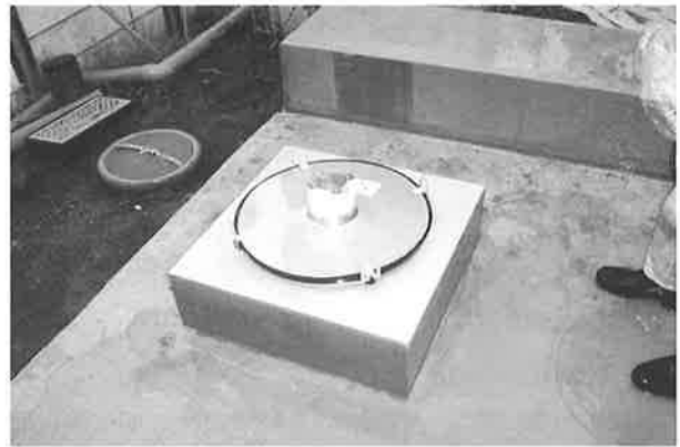
写真3 ベアリング支承の据え付け
