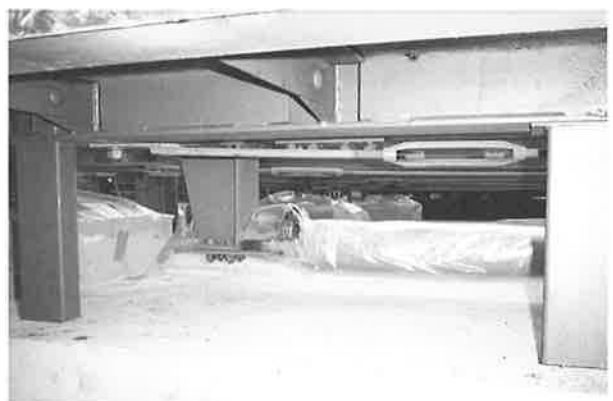
写真5 オイルダンパの取付け
