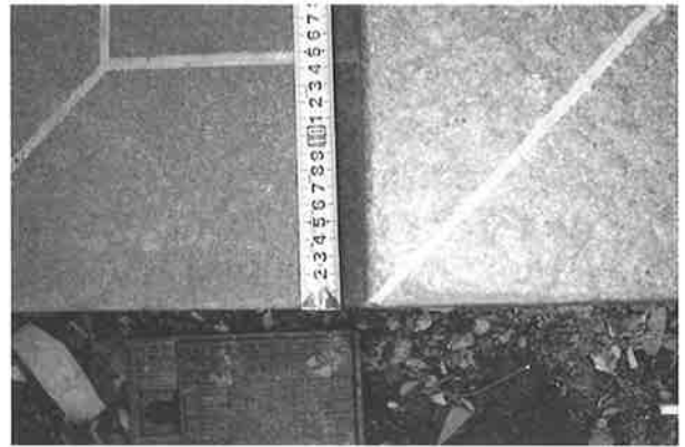
写真8 除加後の建物復元状況
