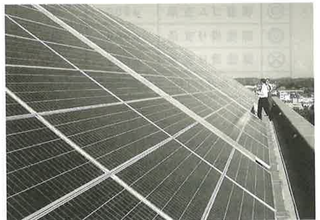
写真-7 屋上ソーラーパネル
