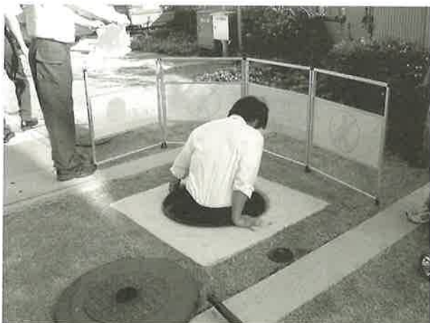
写真-10 免震ピット入口
