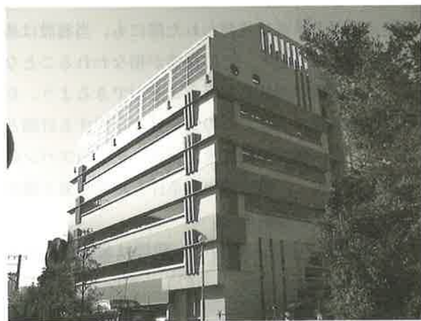
写真-1 建物外観
