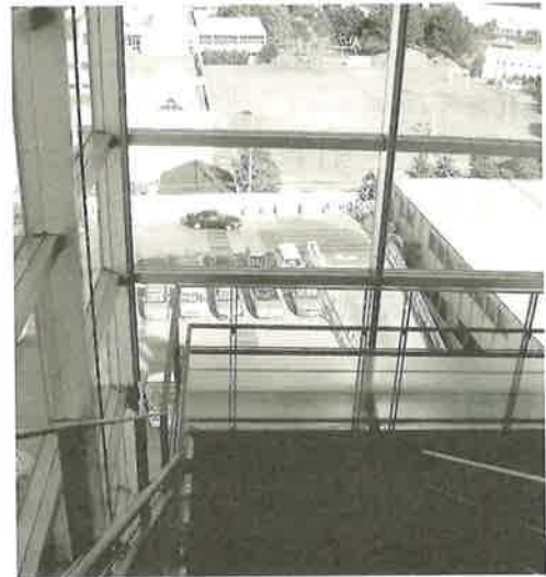
写真-6 屋内階段
