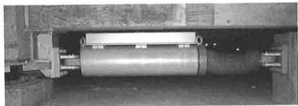
写真2 オイルダンパー
