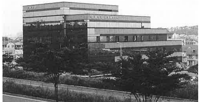
写真7 完成間近の「新学社東京支社ビル」
