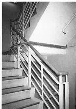
写真6 免震部の階段・手摺
