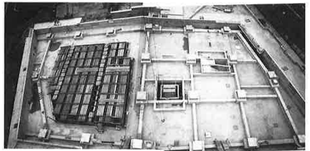
写真5 免震装置設置直後の現場状況
