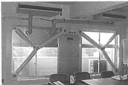
写真—7 非常用出入口部
