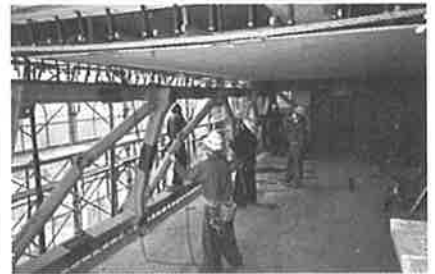
写真—9 建て込みの様子
