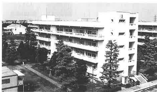
写真-3 建物外観 (3号館)
