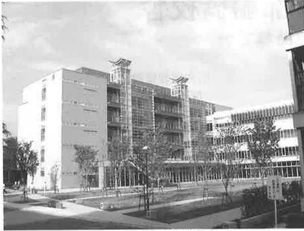
写真-1 建物外観（14号館）
