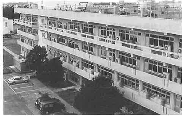
写真—5 建物外観 (8号館)
