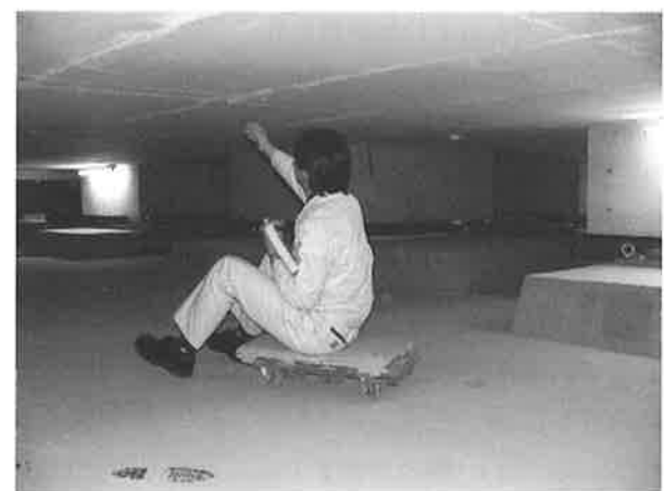
写真4 免震ピットメンテナンス状況
