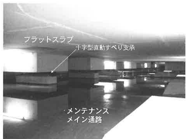
写真3 免震ピット内観
