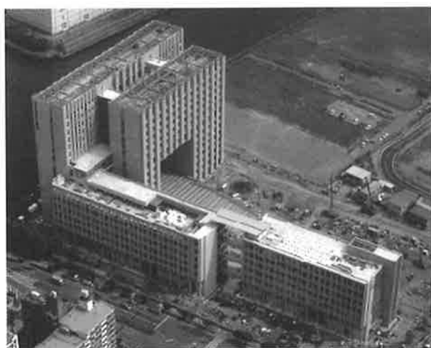
写真1 工事中写真(2005年9月現在)
