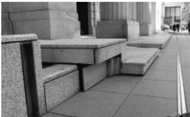
■写真5 建物外周のエキスパンション
