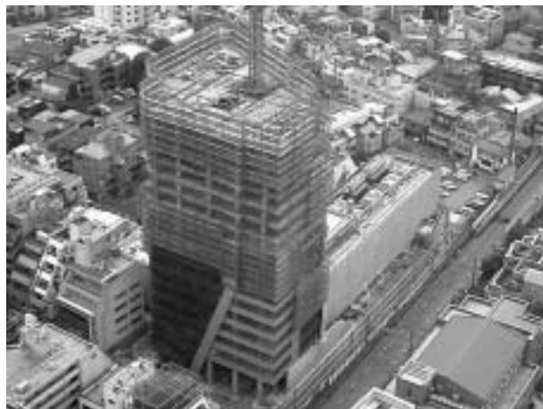
写真1 工事中写真(2006年5月現在)
