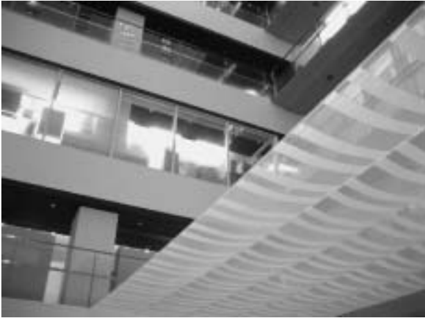
写真9 アトリウム小物落下防止シート
