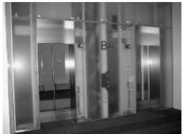
写真3 エレベータ部
