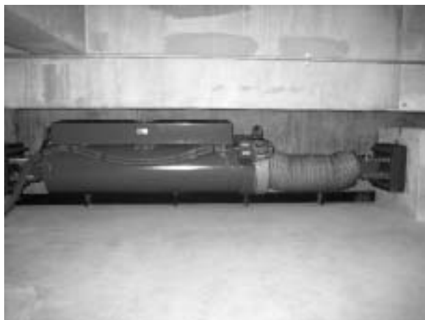
写真7 可変減衰型ダンパー
