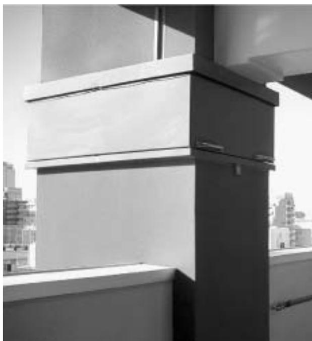
写真3 免震装置耐火パネル
