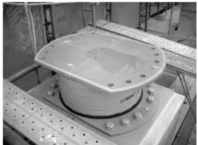
写真2 免震装置設置状況
