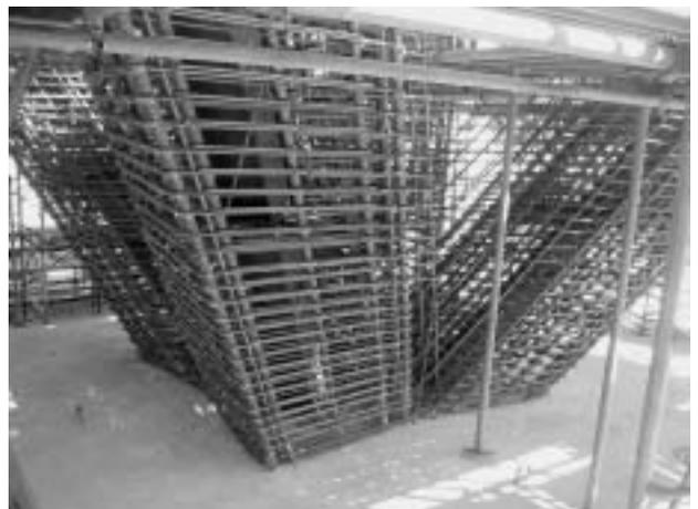
写真2 斜め柱配筋施工中写真
