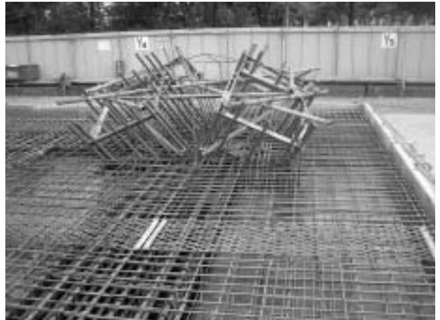
写真1 斜め柱柱脚配筋施工中写真
