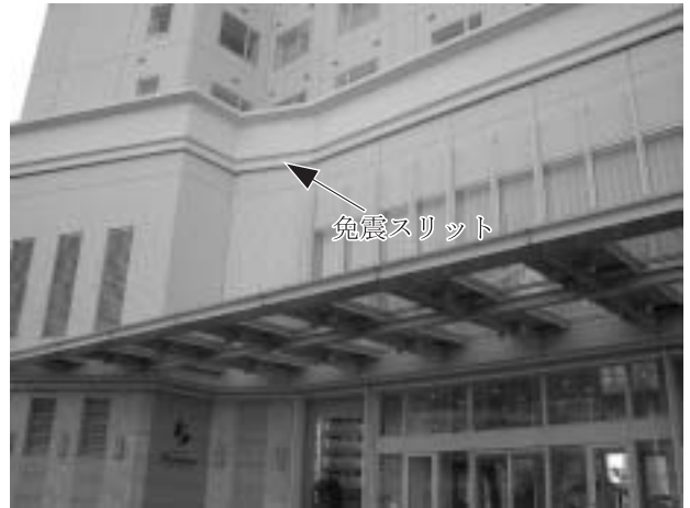
写真-3 外壁部免震スリット
