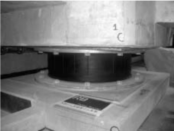
写真-6 天然ゴム系積層ゴムの設置状況
