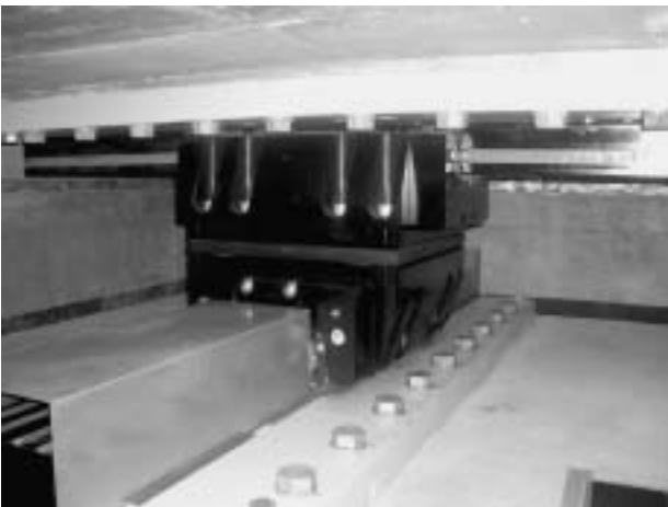
写真-8 直動転がり支承の設置状況
