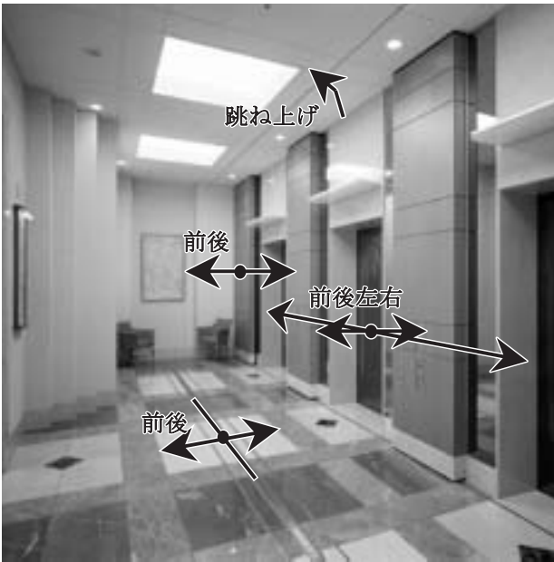
写真-2 1階エレベータホールの免震対応
