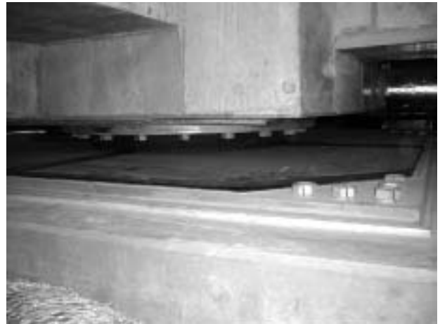
写真-7 弾性すべり支承の設置状況
