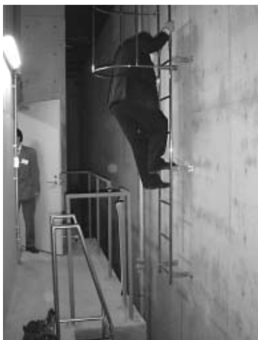
写真3 免震クリアランス内移動中
