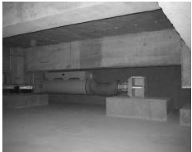
写真6 ダンパー取付部
