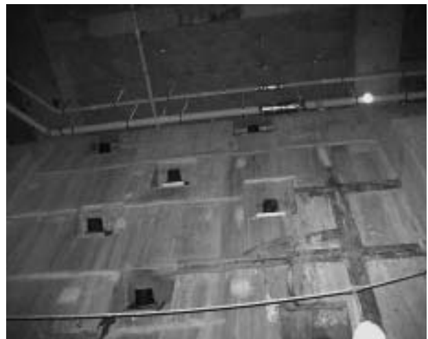
写真2 擁壁と永久アンカー定着部
