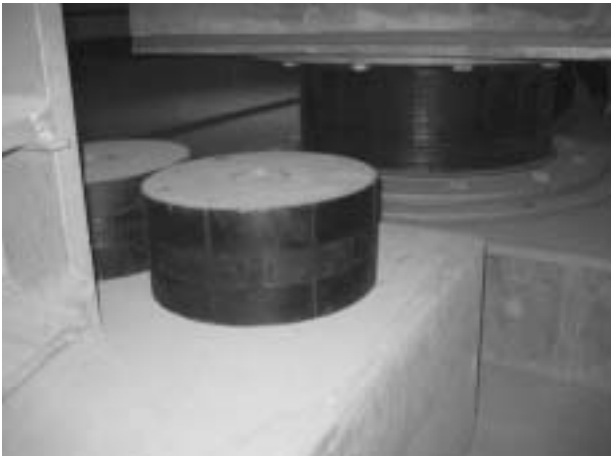
写真9 別置き試験体
