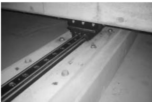
写真6 直動転がり支承交差型免震部材(20基)
