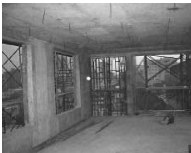
写真1 フラットプレートの施工時(躯体)内観
