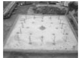
写真3 コンクリートの充填性確認状況
