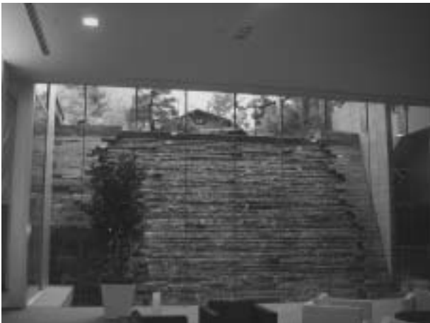
写真2 擁壁を利用した流水壁
