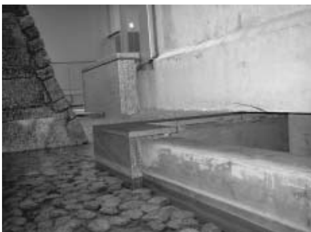
写真7 免震層と水路の状況
