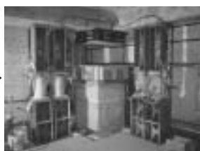
免震ゴム取付前の状況
