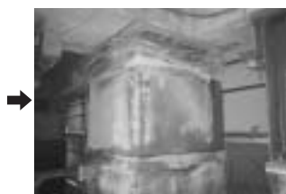
柱切断完了 (ワイヤーソーによる切断)
