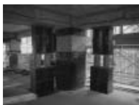
柱切断前の状況
