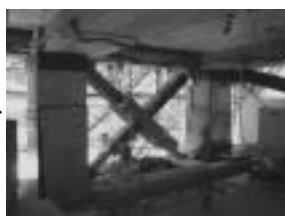
仮設ブレースの設置状況 (工事中の耐震安全性を確保)
