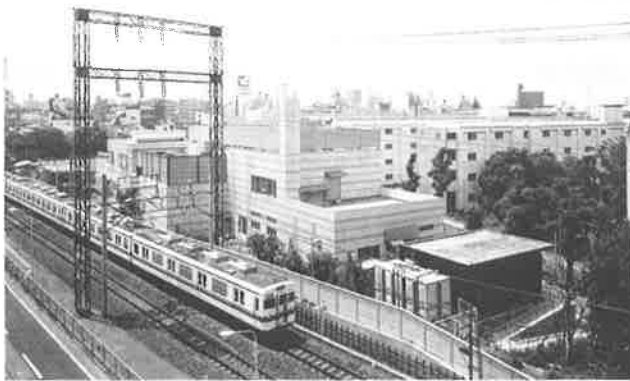
写真二 建物全景
