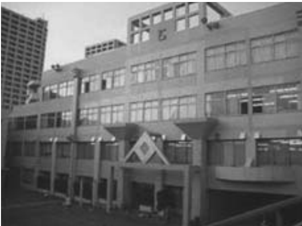
写真4 増築前の建物全景
