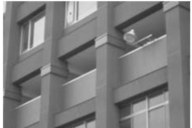
写真5 柱の連続性を持たせた免震階
