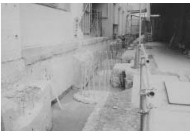
写真9 補強用杭の施工後の状況
