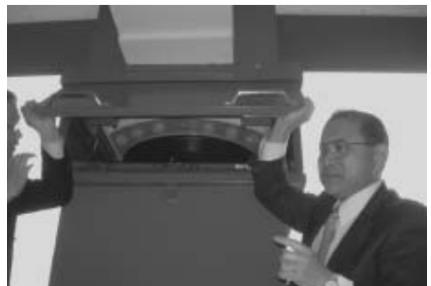
写真6 免震装置を囲む開閉可能耐火プレート
