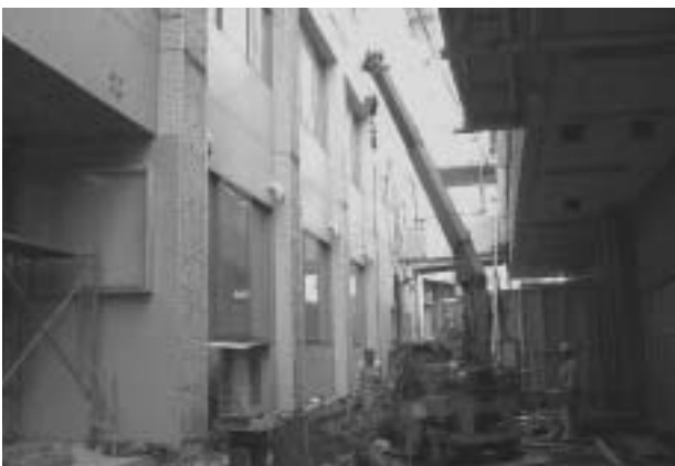
写真8 補強用杭の施工状況
