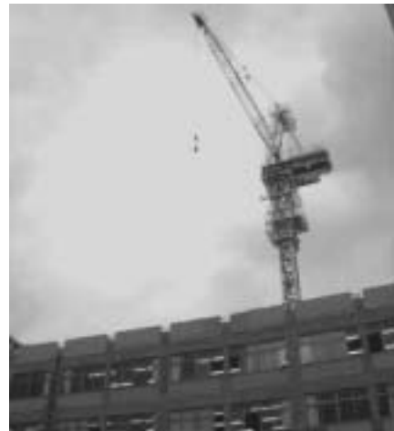
写真10 工事中の揚重機設置状況
