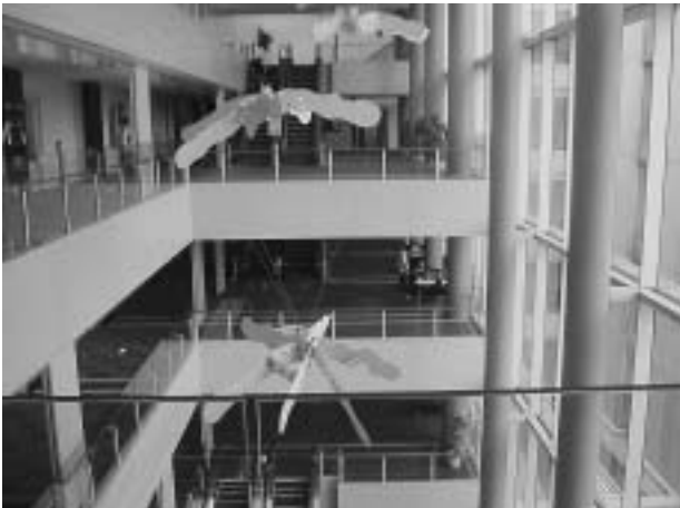
写真3 教室棟吹き抜け部
