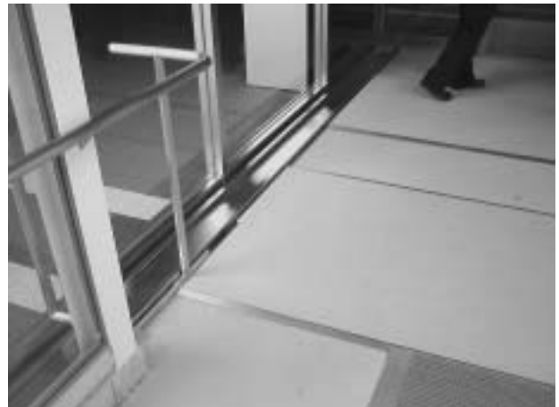
写真11 ローラー側の床のおさまり
