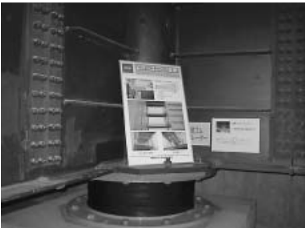
写真9 講義で説明した積層ゴムアイソレータ
