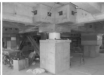
柱周り補強後
