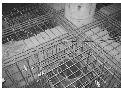
基礎つなぎ梁補強配筋
