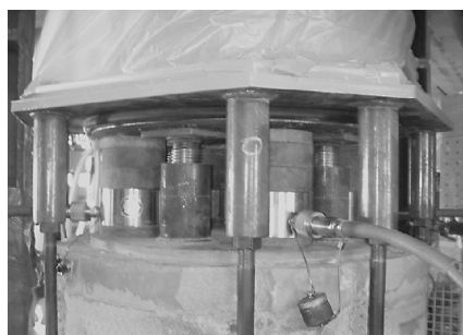
プレロードジャッキ・プレロードケース設置
