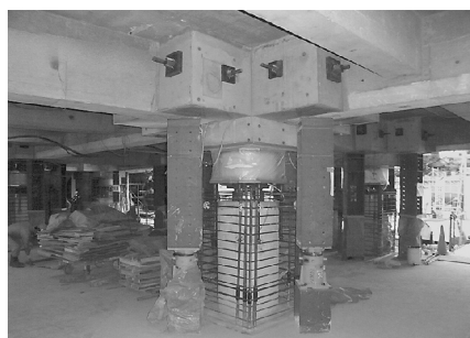
免震支承取付
