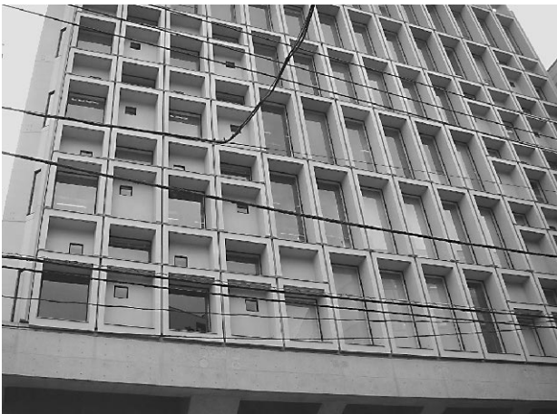
写真8 ファサードの外壁耐震壁
