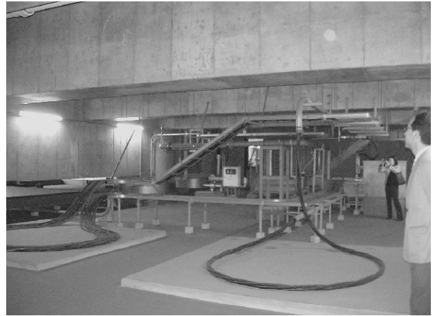
写真9 免震層見学風景
