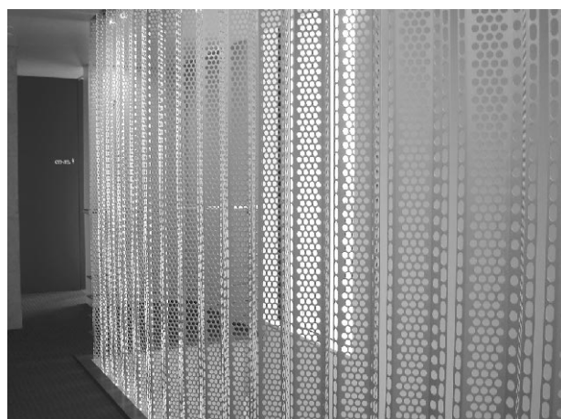
写真5 階段室スクリーン(有孔切板)
