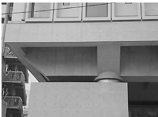
写真2 免震層部分外観
