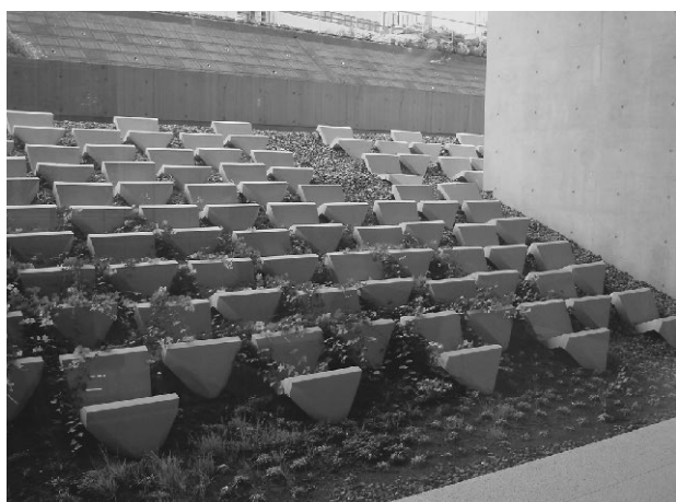
写真4 エントランスホール水流抑制ブロック
