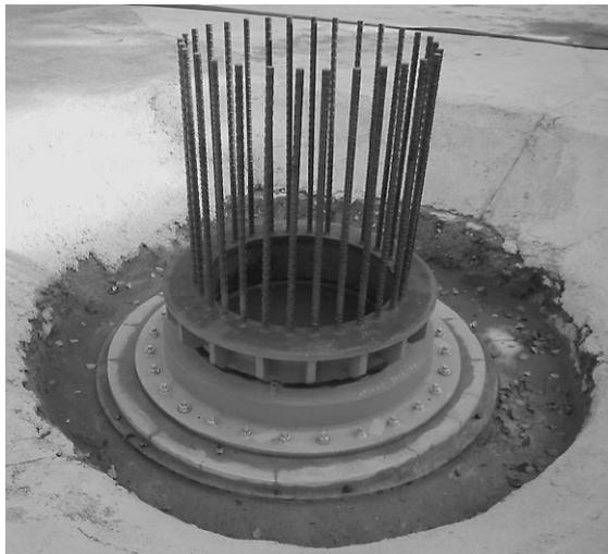
写真2 P/Rパイル工法PA型支承
