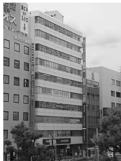
写真1 既存建物外観
