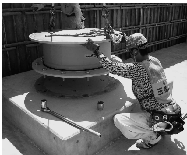
写真2 免震材料の設置
