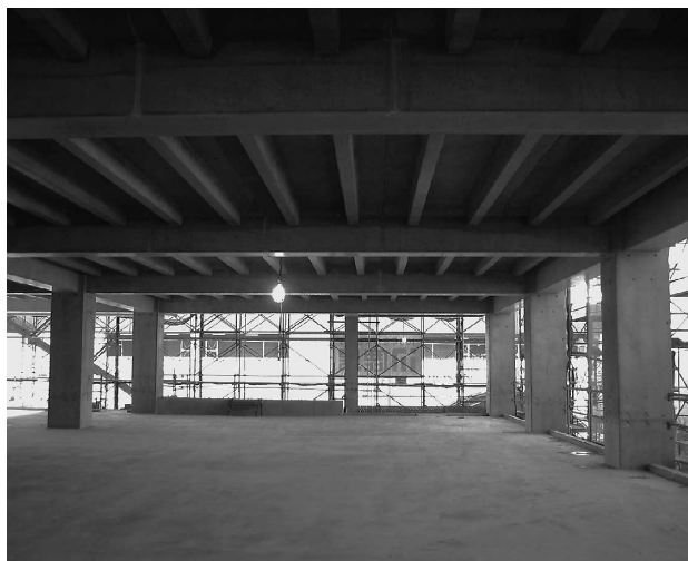
写真1 上部架構内観 (12.6mスパン)
