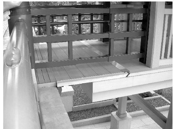
写真10 渡り廊下の連結部
