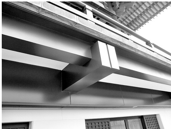
写真8 2階はね出し梁の状況
