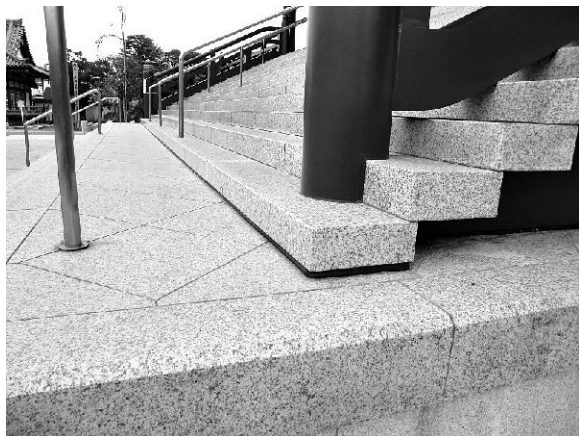
写真9 正面階段エキスパンション部
