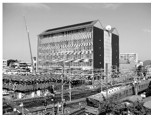
写真3 竣工間近の南東側外観
