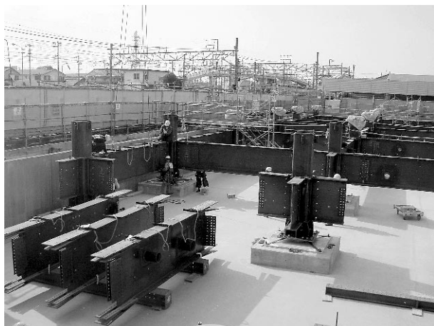
写真1 鉄骨0節建方状況
