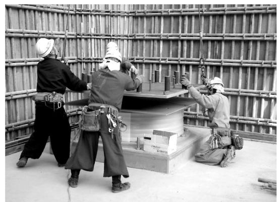
写真3 天然ゴム系積層ゴム設置状況
