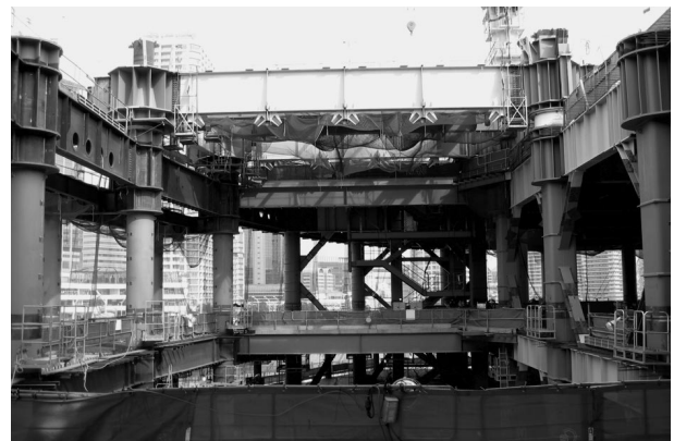
図8 免震層鉄骨建方状況
