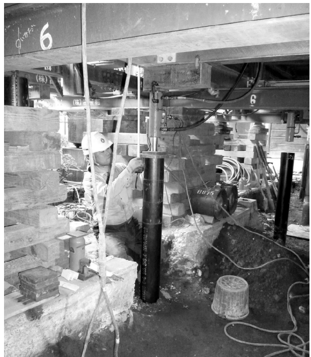
写真4 施工写真2(杭圧入)
