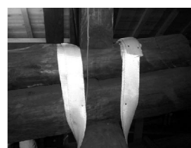
写真2 SRF工法
