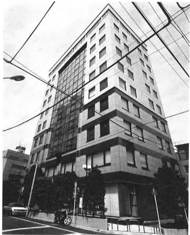
写真-2 建物全景
