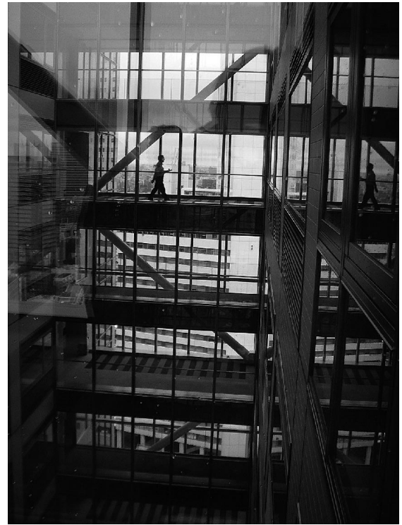
写真2 高層部 吹抜け
