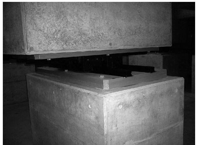
写真10 リニアスライダの設置状況
