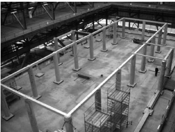
写真3 初重柱の施工状況
