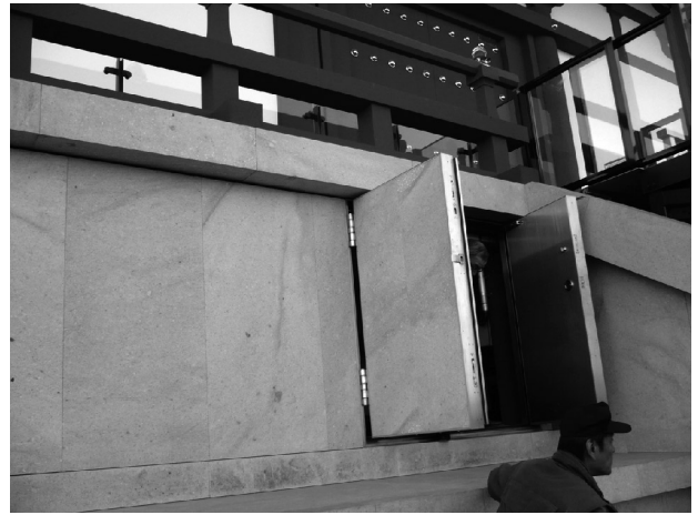
写真8 免震層への出入り口
