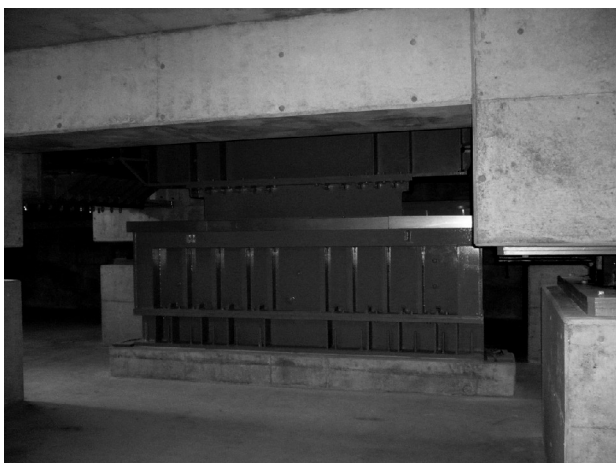
写真12 壁型粘性体ダンパー
