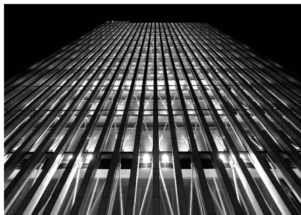
写真1 北面ファサード見上げ(撮影：東出清彦)
