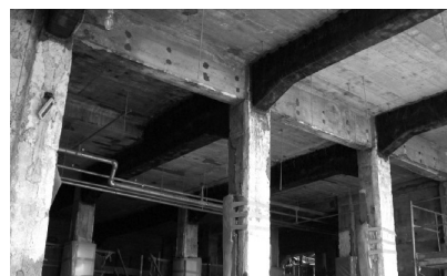
写真5 炭素繊維巻き補強
