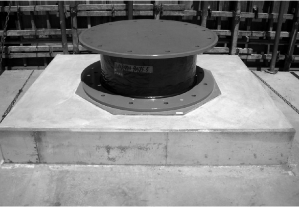
写真3 LRB 設置状況
