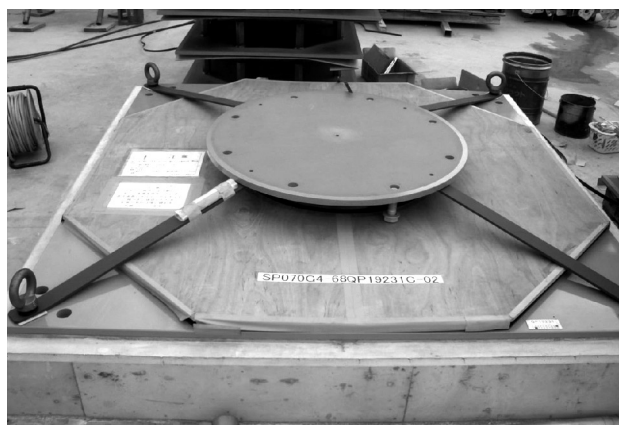
写真4 すべり支承設置状況
