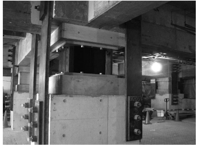
写真4 免震装置の設置状況
