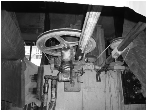
写真2 ワイヤーソーでの柱の切断
