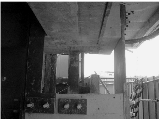
写真3 既存柱切断時の様子
