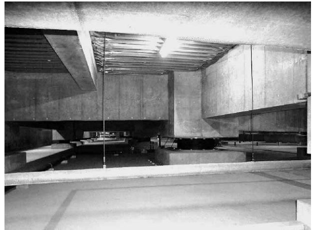
写真2 免震層の状況
