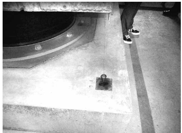
写真3 下げ振りの設置状況
