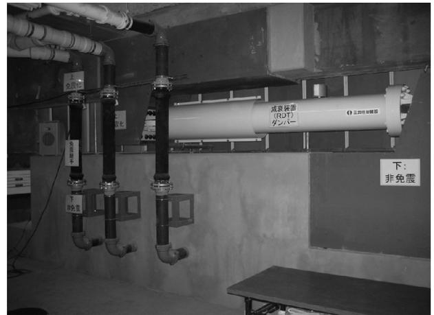
写真3 粘性減衰装置と免震継手
