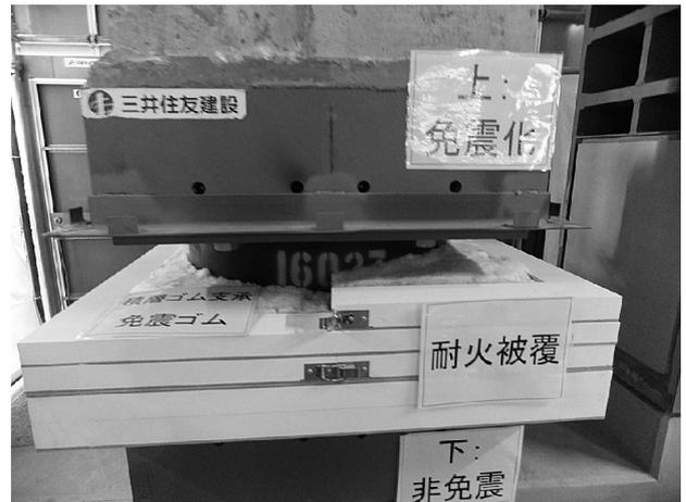
写真2 積層ゴム系免震装置設置状況
