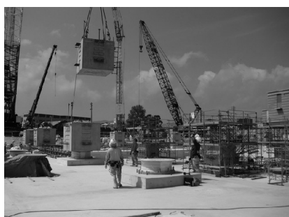
工程1 免震ブロック架設
