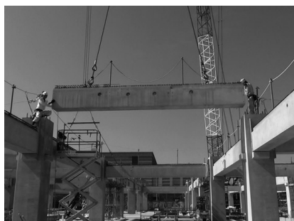
工程4 PCa梁の架設
