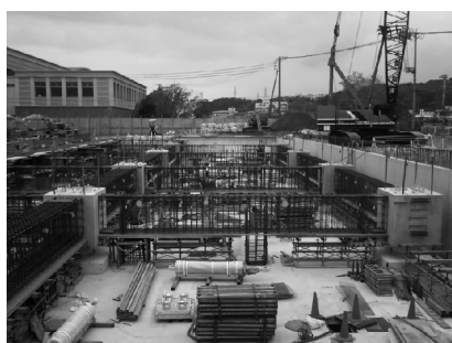
工程2 1階RC梁の配筋
