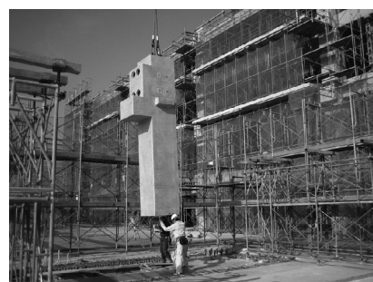
工程3 PCa柱の架設
