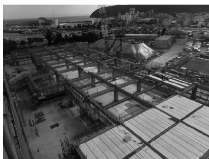
工程5 PCa床版の架設
