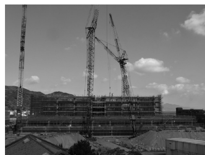
建物全景 (H24 年3月撮影)
