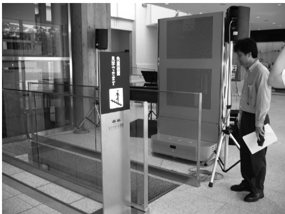
写真14 免震層見学階段
