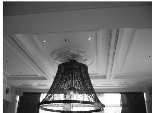
写真10 TMDが設置されている天井
