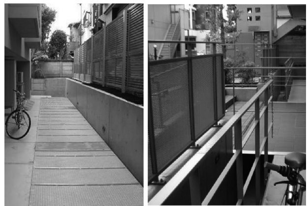
写真4 外構周り(左:南面、右:西面)
