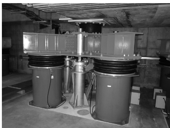
写真6 3次元免震装置設置状況
