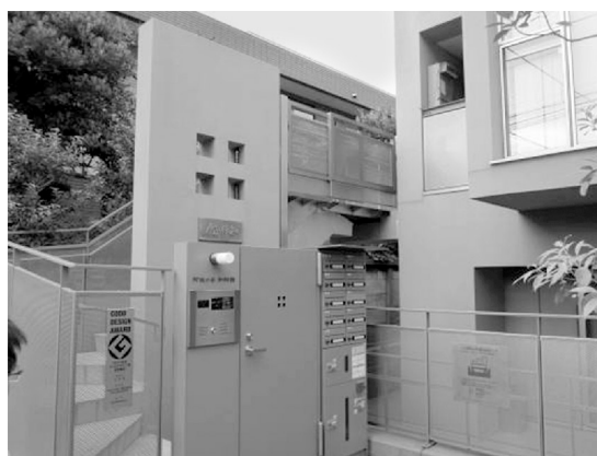
写真10 2階住戸部への階段入口
