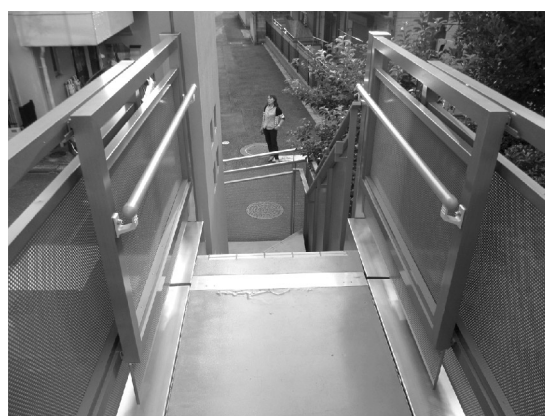
写真9 外部階段 Exp.J(2階床面)
