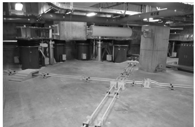
写真5 免震部(南側より北面を臨む)
